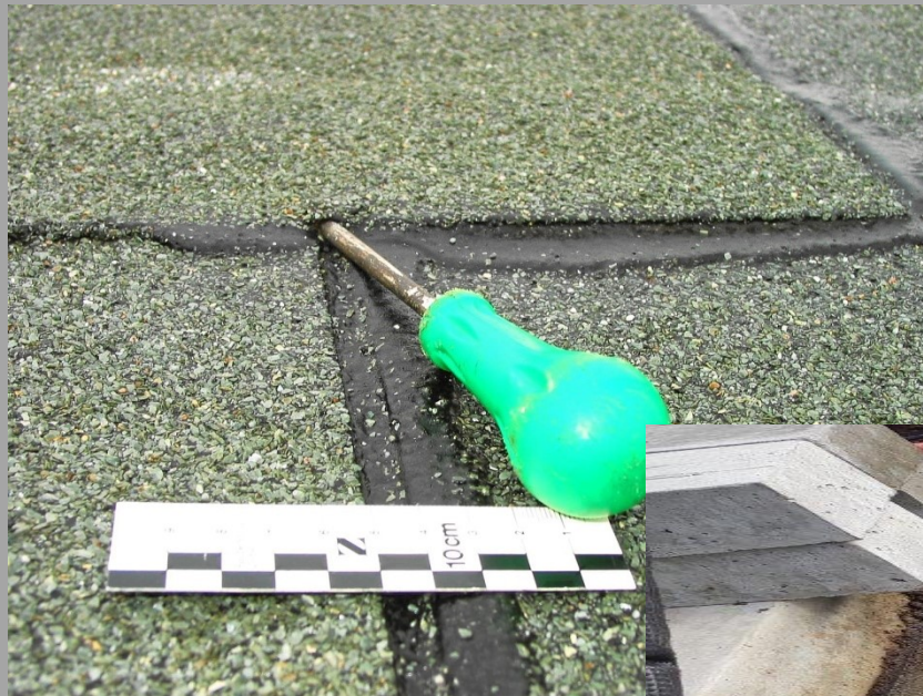
Nahtöffnungen im T-Stoß-Bereich
